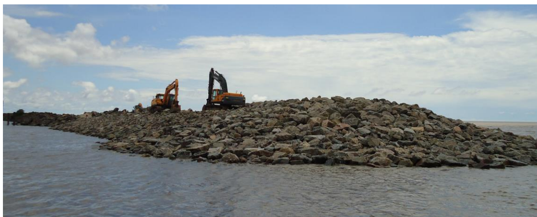
Imagen 1. Acortamiento de escollera Este y reconstrucción de morro
